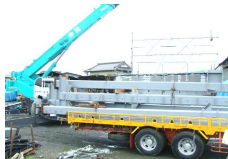
鉄骨輸送 クレーン積込み
