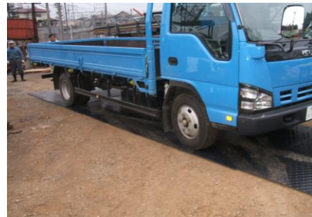
耐水ベニヤ床板 補強
