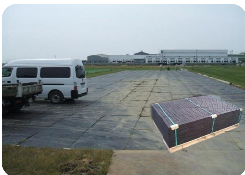
転用地仮設地盤 事務所 資材置き場
