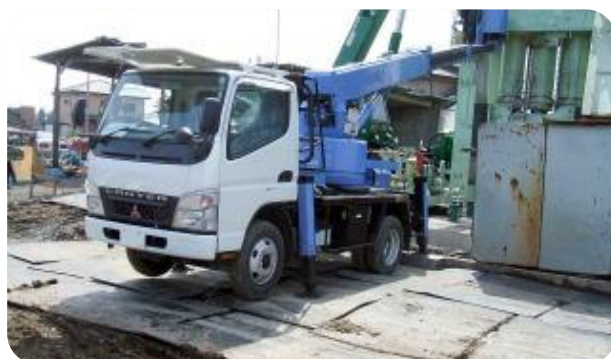
軟弱地作業敷板 重機資材運搬路
