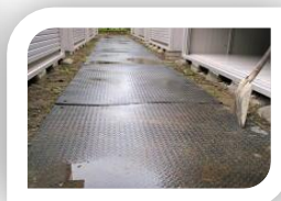
土面の通路板
