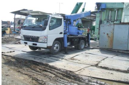
プレス据え付け現場
