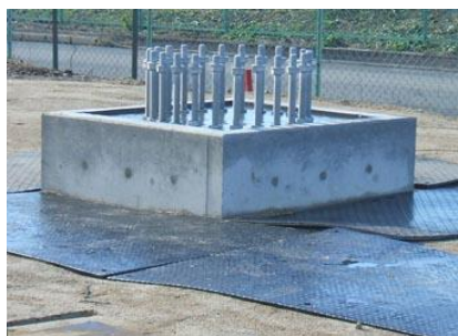
基礎周囲の作業マット
