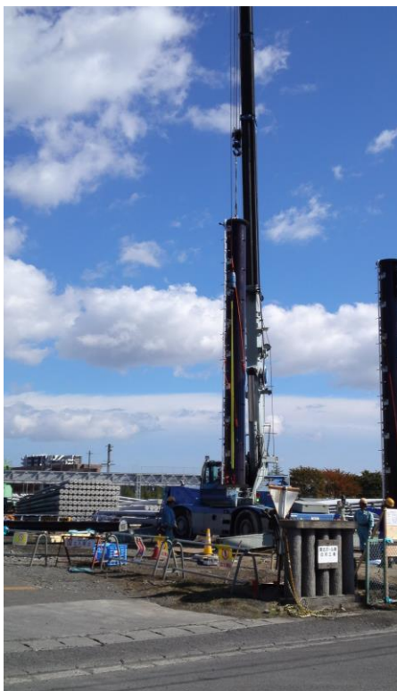
携帯基地局鉄塔建設現場
